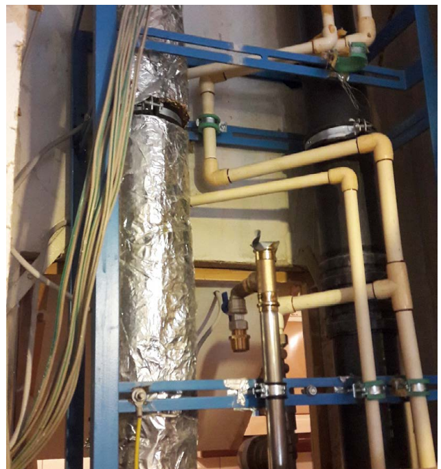
Sanierung der Steigstränge – Tiefengruber Straße
