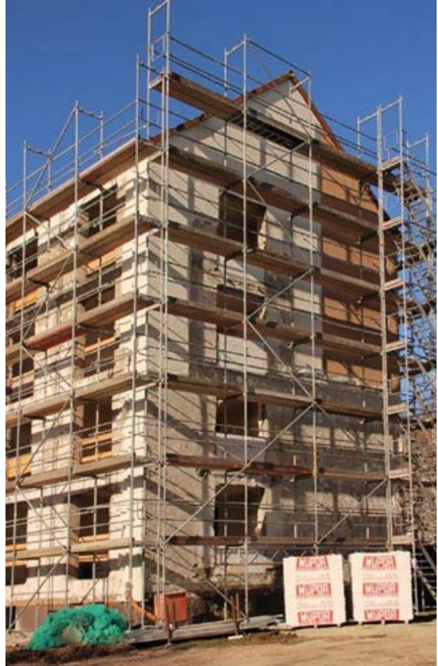
Das Gerüst steht – Die Aussenarbeiten beginnen
