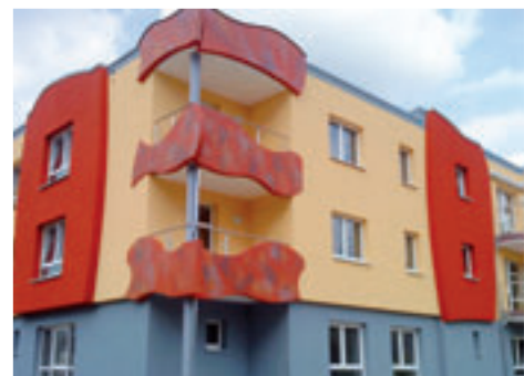
Fertigstellung der Malerarbeiten
